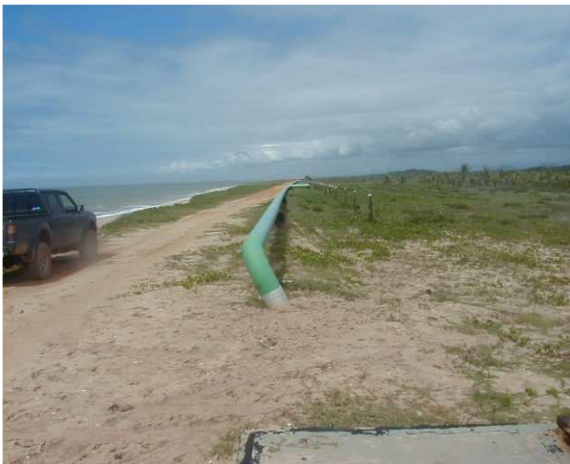
Figura 1 – Vista do final do trecho terrestre do emissário de Cabiúnas
